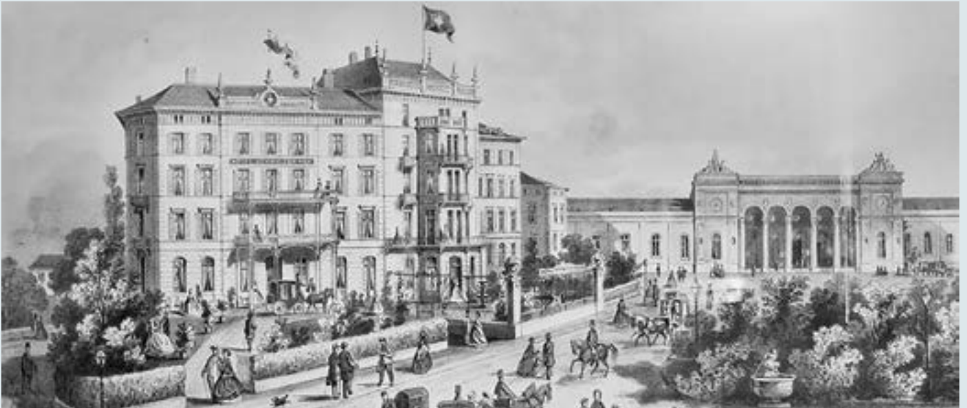
■ Basel verfügte bereits 1844 über eine Zugverbindung nach Strassburg – drei Jahre vor der Strecke Zürich-Baden, die als älteste Schweizer Bahnlinie gilt. 1860 ging der Centralbahnhof auf, in dessen Gegend viele Hotels entstanden. Das erste war 1864 der Schweizerhof. Das Haus wurde 1896 verkauft und befindet sich nun seit vier Generationen in Familienbesitz.
